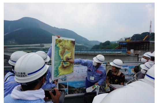
阿蘇大橋滑落現場の見学
