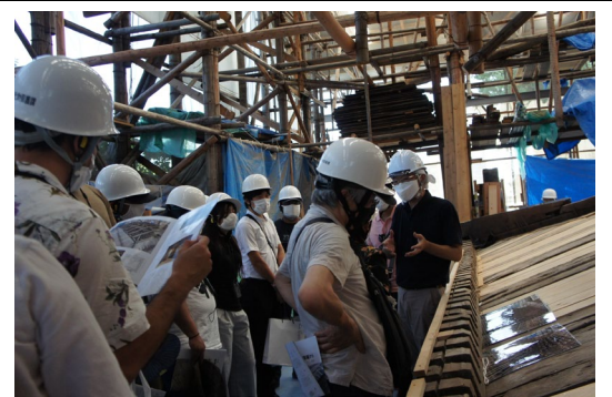
本隆寺の改修技術の見学
