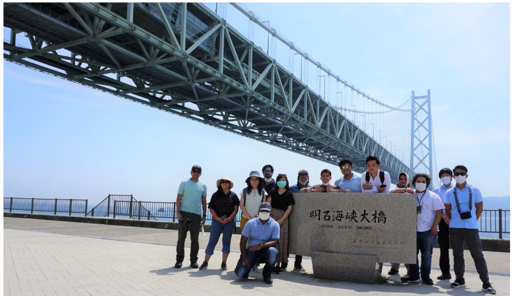
明石海峡大橋
