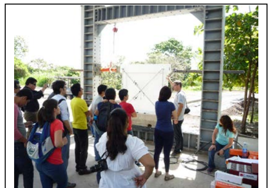
写真2: コンクリートブロックを用いた枠組組積造壁試験体の加力準備(UES 実験棟)
